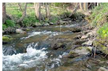
Abb. 5: Noch anhaltendes Einschneiden eines Baches in den Untergrund
